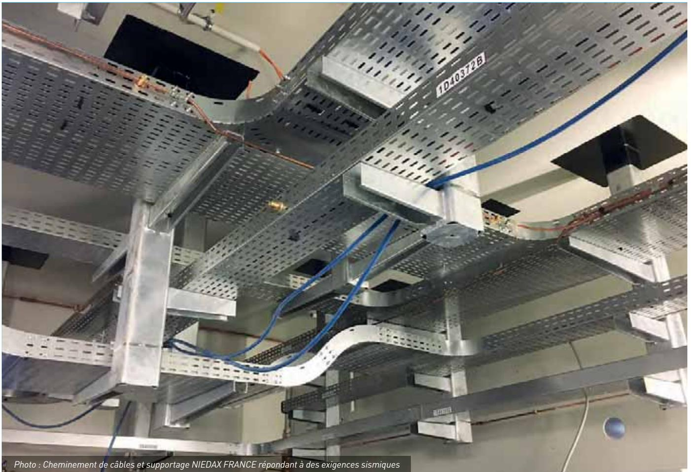
Photo : Cheminement de câbles et supportage NIEDAX FRANCE répondant à des exigences sismiques
