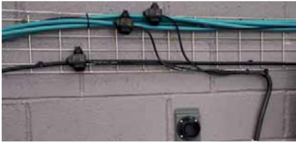
Câbles basse tension (0,6/1kV) mono-conducteurs U1000-AR2V constitués d'un assemblage de quatre câbles unipolaire XLPE/HFFR. Raccordement des bornes avec les connecteurs NEOCLICK®.
